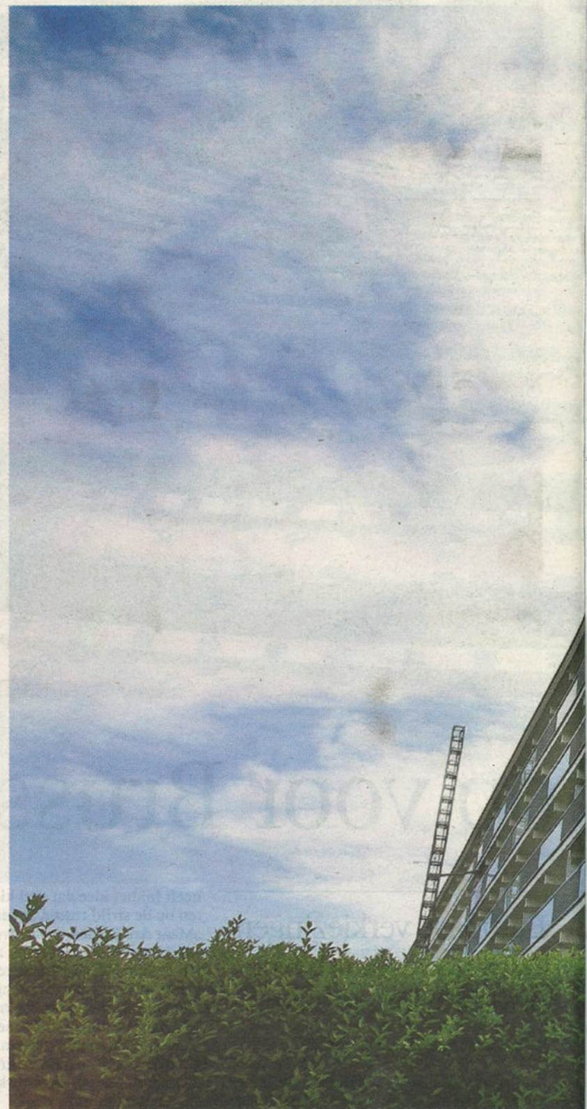
De verbetering van de flat aan de Erasmuslaan in Hilversum is de omvangrijkste ho
