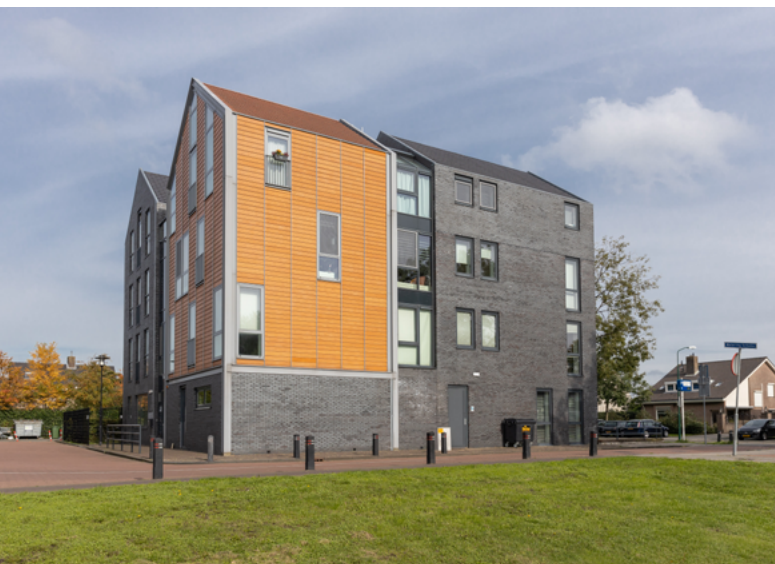
Appartementengebouw Stichting Aunders
