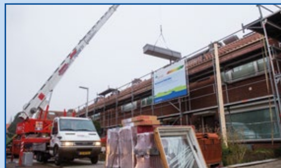
Vervangen van al het bestaande glas (enkel en dubbel) door HR++ beglazing.
