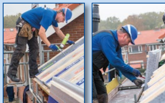
Buitengevels controleren en bijvullen met isolatiemateriaal.
