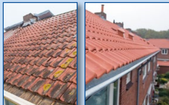
Vervangen van diverse onderdelen rondom het dak.
