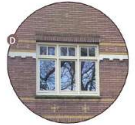
Architectonische details: rollaag, spekbanden en onderdorpels van baksteen in de Laan van
