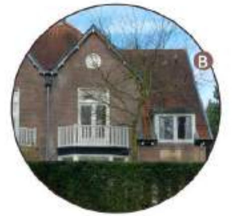
Lage goten, en doorlopend dakvlak in de Lohmanlaan.
